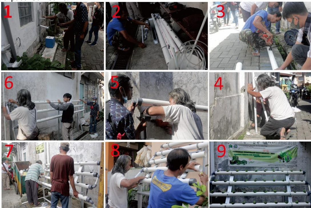
Gambar 6 Proses Pembuatan dan Pemasangan Instalasi Hidroponik
