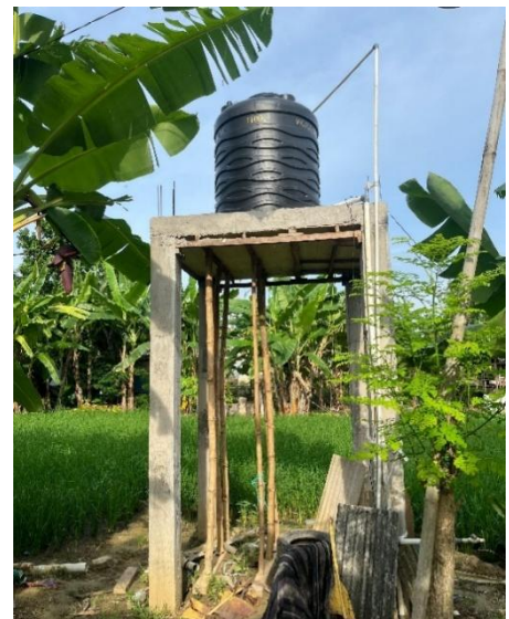
Gambar 1. Menara Tandon dan Tandon Air kapasitas 1100 Liter
