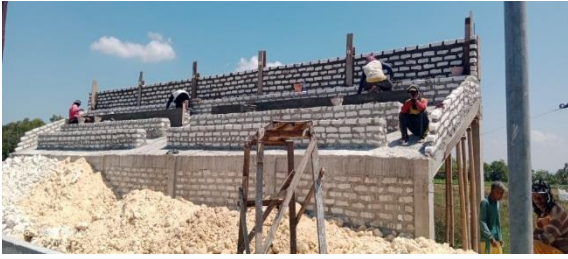
Gambar 9. Pekerjaan Pasangan Batu Putih
