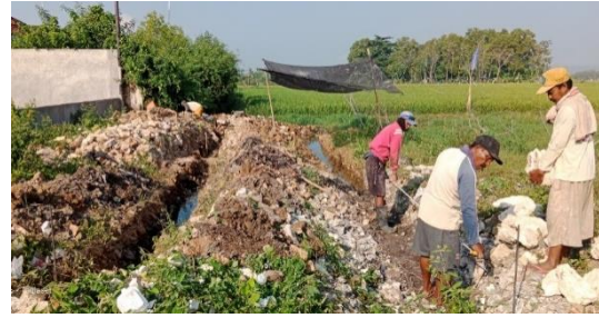
Gambar 2. Pengukuran dan Galian Pondasi
