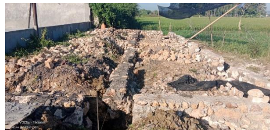
Gambar 3. Pekerjaan Pondasi Batu Kali
