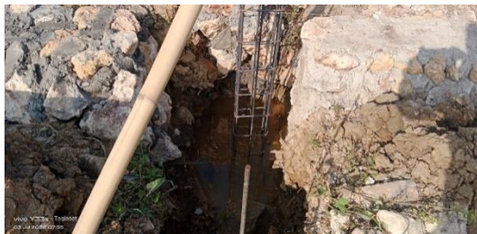
Gambar 4. Pekerjaan Penulangan Pondasi Setapak
