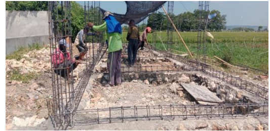
Gambar 6. Pekerjaan Penulangan Sloof dan Kolom
