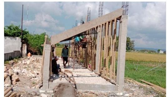
Gambar 7. Pekerjaan Kolom dan Bekisting Balok dan Plat
