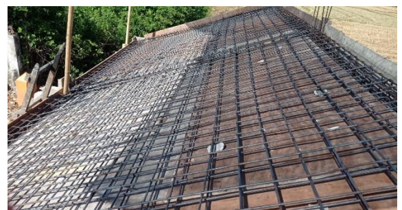
Gambar 8. Pekerjaan Penulangan Plat
