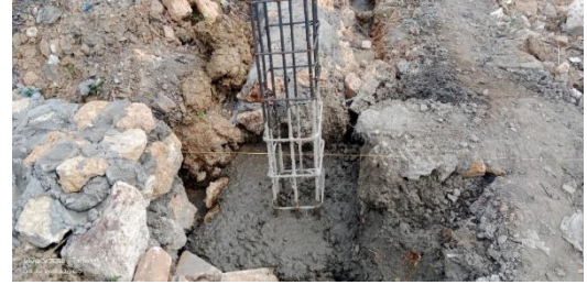
Gambar 5. Pekerjaan Pengecoran Pondasi Setapak
