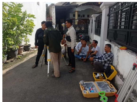
Gambar 3. Pengukuran Menggunakan Total Station
