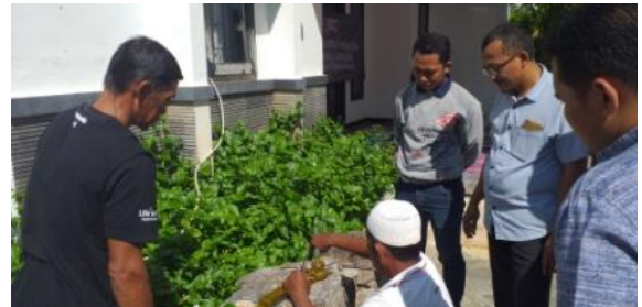
Gambar 18. Praktek Pekerjaan Pembesian
