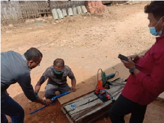
Gambar 7. Praktek Pekerjaan Pembesian
