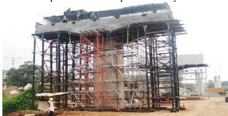
Gambar 2 Cor Pier Head Cast in situ Tahap 1(foto lapangan)
