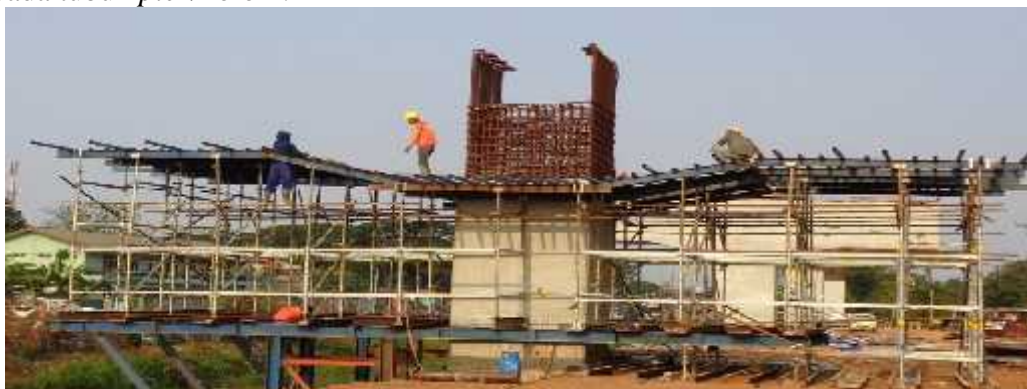
Gambar 6. Pemasangan Perancah Shoring Peri UP dan Bekisting Bagian Bawah(foto lapangan)
