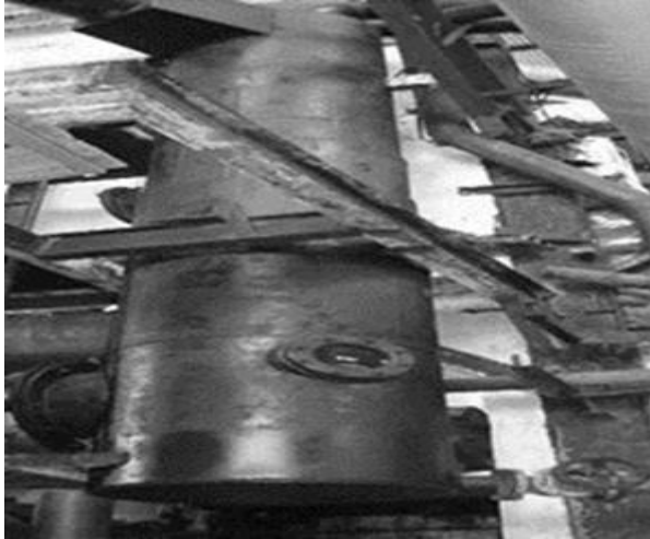
Gambar 7. Proses Pengerjaan Tangki Reservoir
